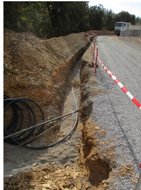
Photographie 13. Exemple de tranchée en bordure de piste - RES
