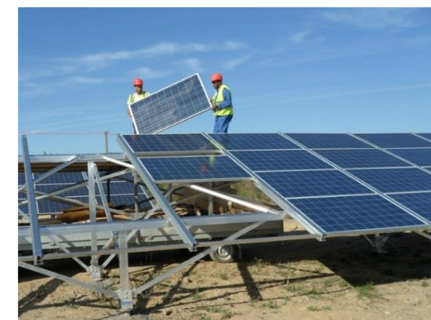
Photographie 12. Exemple de mise en place des panneaux sur les structures - RES
