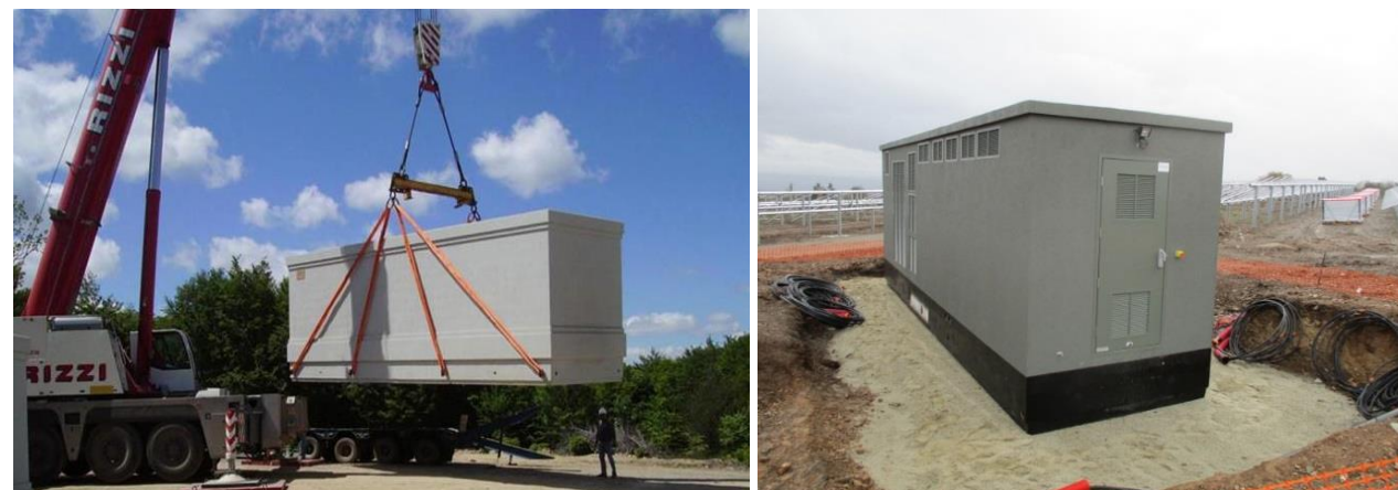
Photographie 14. Installation d'un poste électrique - RES
