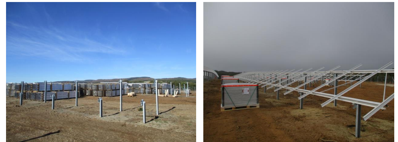
Photographie 11. Assemblage des structures sur site - RES
